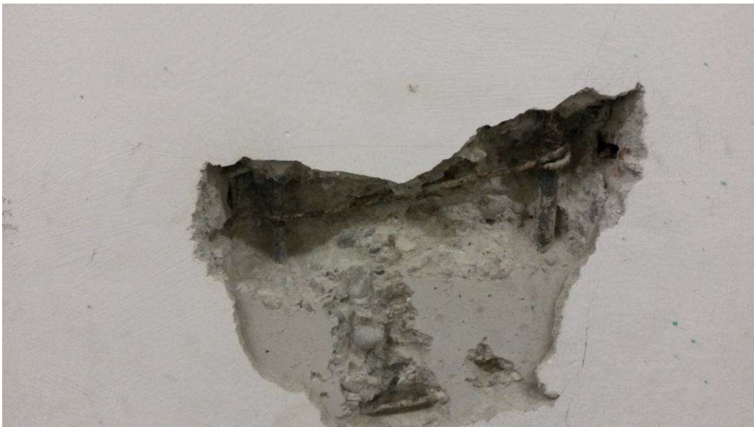
Armatura pilastro
