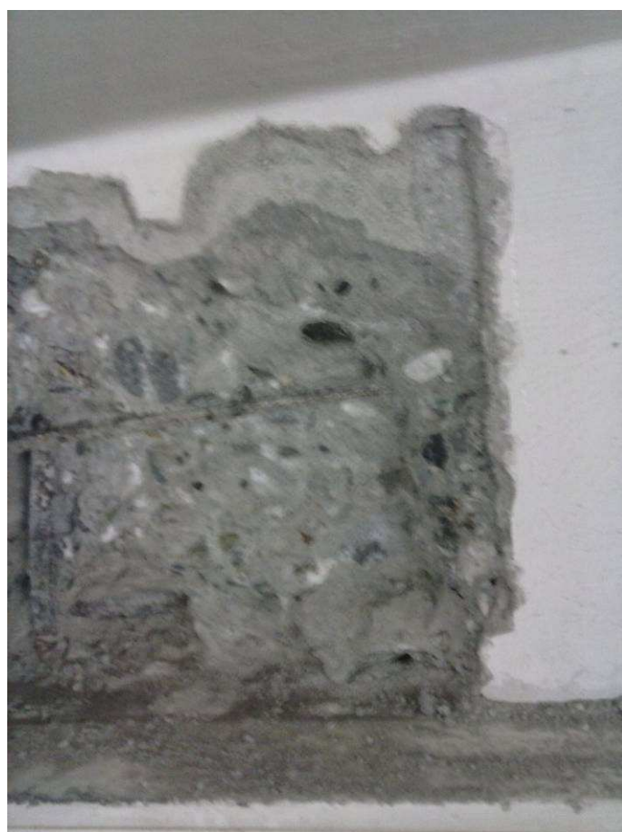
Particolare nodo trave pilastro
