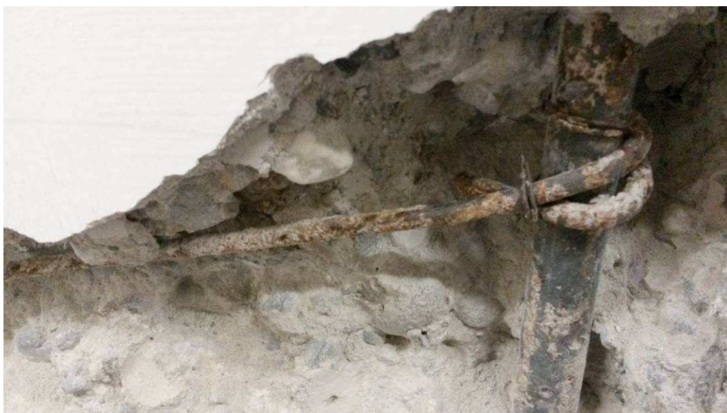
Particolare gancio staffatura pilastro
