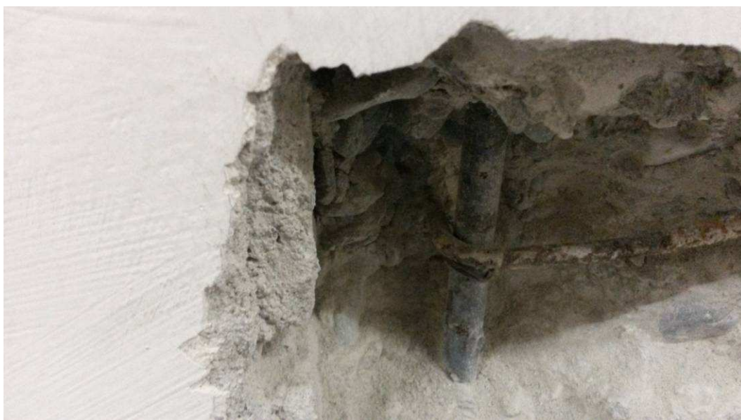
Particolare staffa pilastro
