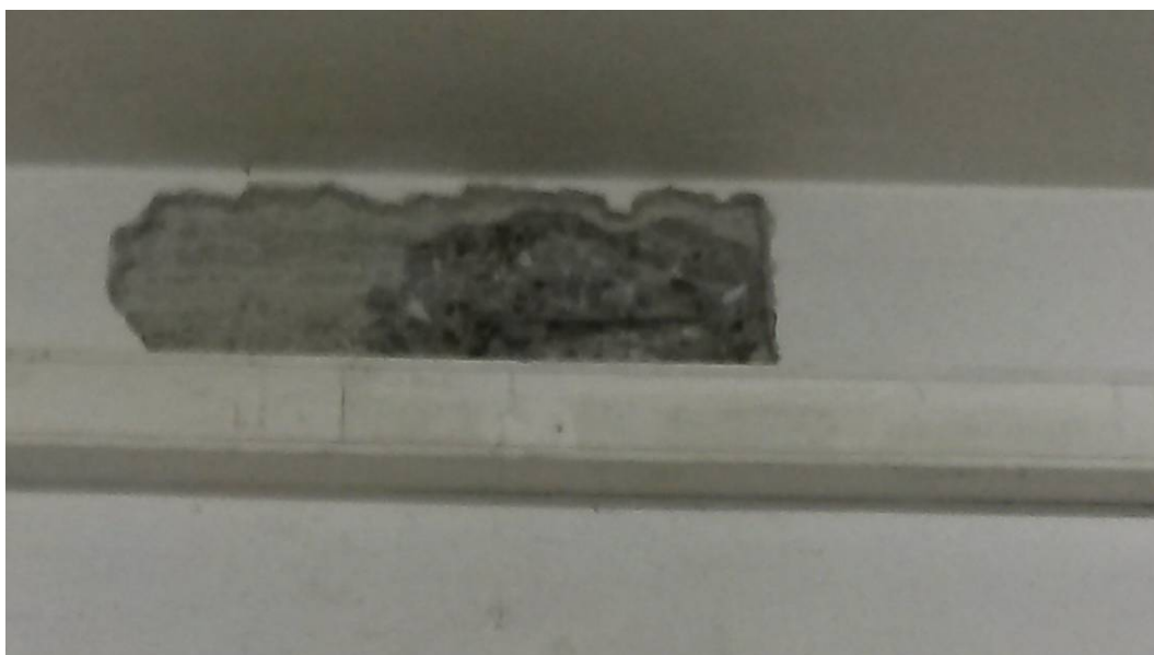
Particolare nodo trave pilastro
